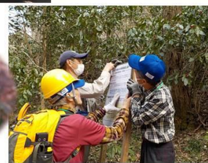
「高尾山利用ルール」の取付け
